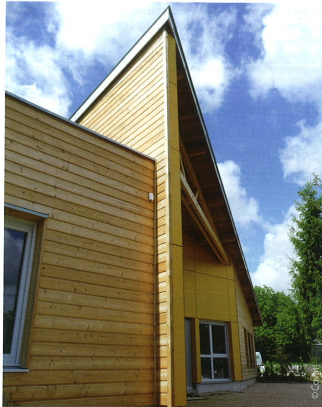
MAISON DE LA PETITE ENFANCE IS-SUR-TILLE (CÔTE-D'OR), 663 M 2 BÂTIMENT INAUGURÉ EN AOÛT 2009. MONTANT DU MARCHÉ : 1 075 195 € HT
